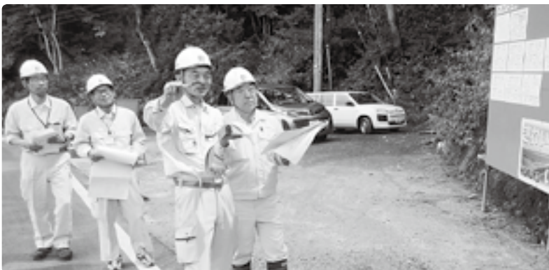
大町建設事務所管内の現地調査。 主要地方道大町麻績インター千曲線の 相川トンネル下の工事現場
